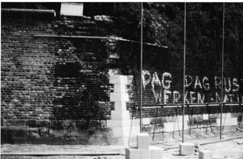
Figuur 3. De verticale mergelketting van Erfprins-West wordt geheel vernieuwd met mergelblokken; niet bepaald Muurhagedisvriendelijk (Foto: B. Kruyntjens).
