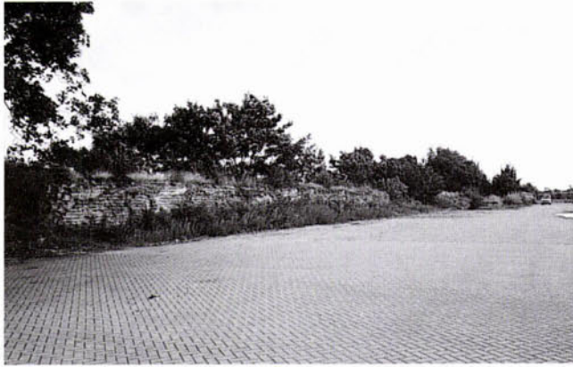
FIGUUR 2a. Courtine bij het spoorwegemplace- ment Boschpoort. Huidige situatie (foto: B. Kruyntjens).
